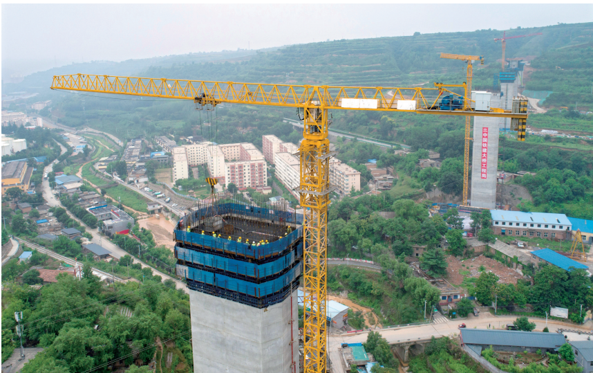
7月15日，中国铁建大桥工程局施工人员在西延高铁王家河特大桥作业（无人机照片）。当日，由中国铁建大桥工程局承建的西（安）延（安）高铁王家河特大桥主墩顺利封顶。王家河特大桥位于陕西省铜川市王益区境内，全长1066米，为西延高铁全线重点控制性工程。西延高铁是国家高速铁路网包（银）海高速铁路通道的重要组成部分。线路建成投入运营后，西安至延安的运行时间将从目前的2个半小时缩短至1小时左右。新华社记者 张博文 摄
