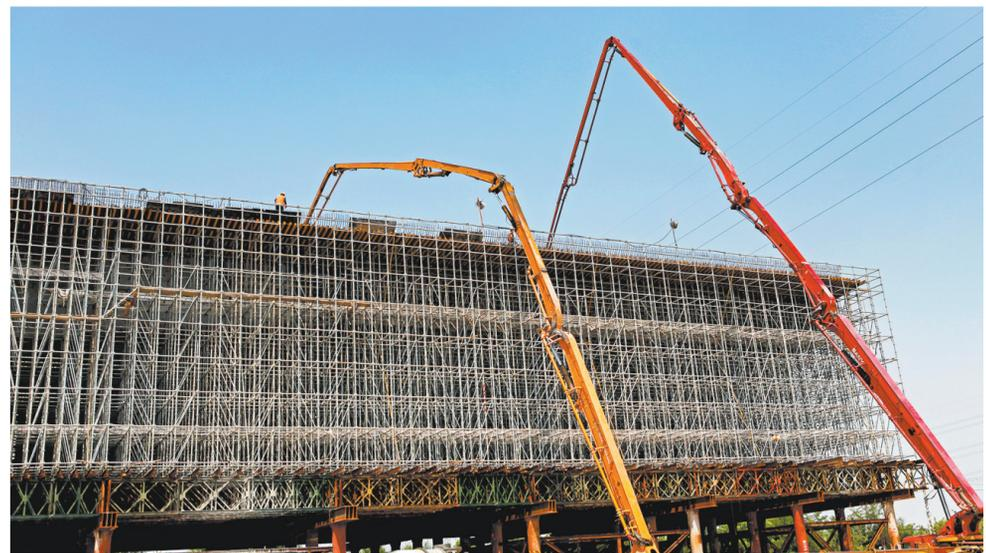
近日,在侯马市村南同蒲铁路跨线桥建设工地,工人们正在进行桥墩混凝土浇筑作业。程村上跨同蒲铁路跨线桥是国道108项目关键控制性节点工程,目前桥梁建设已取得阶段性进展。李现俊 摄
