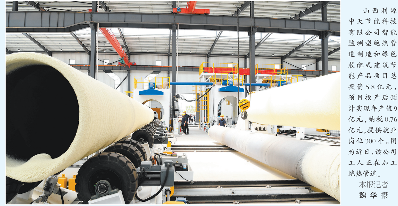
山西利源中天节能科技有限公司智能监测绝热管道制造和绿色装配式建筑节能产品项目总投资5.8亿元，项目投产后预计实现年产值9亿元，纳税0.76亿元，提供就业岗位300个。图为近日，该公司工人正在加工绝热管道。 本报记者 魏华 摄
